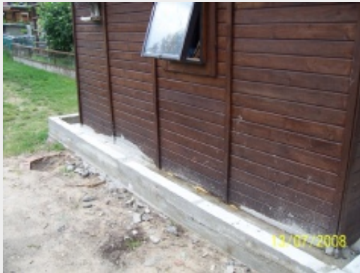
Fundamente für die neue Hütte, die alte wird noch entfernt
